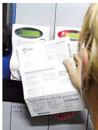
Controllo dei contatori della luce
