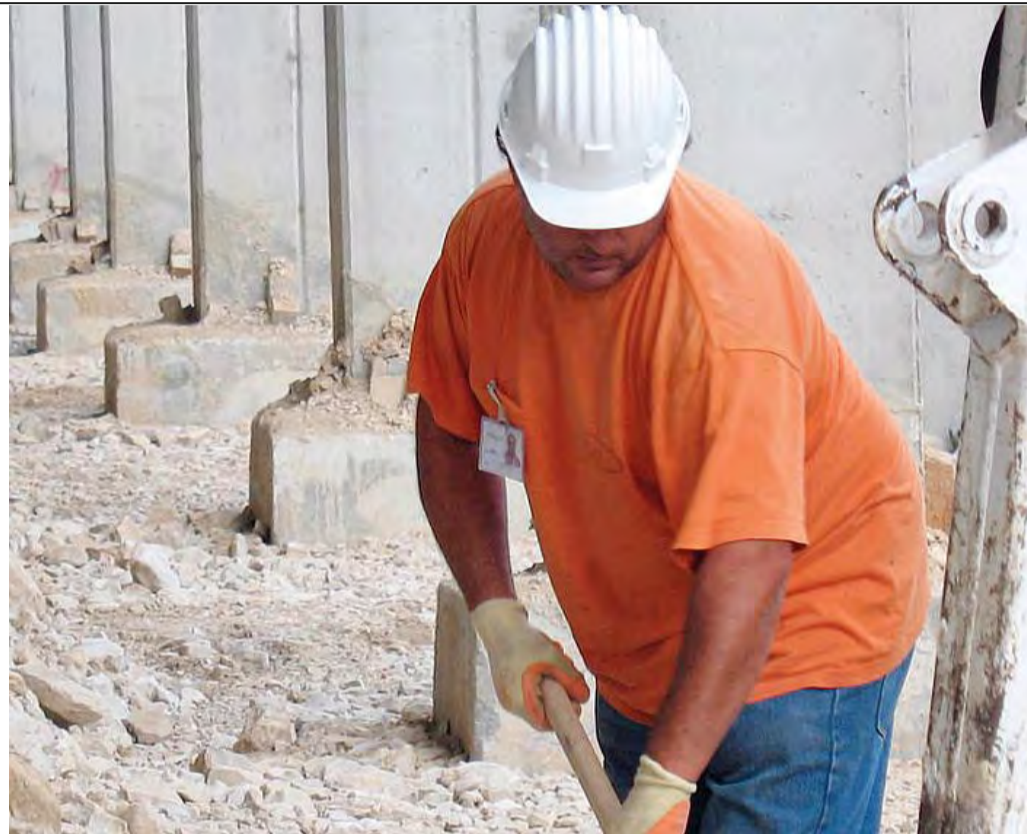
Un operaio al lavoro in un cantiere edile
