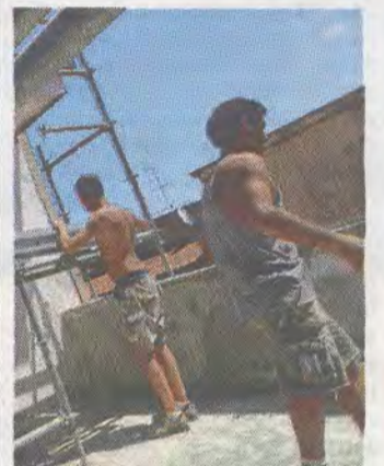
Operai al lavoro in un cantiere edile
