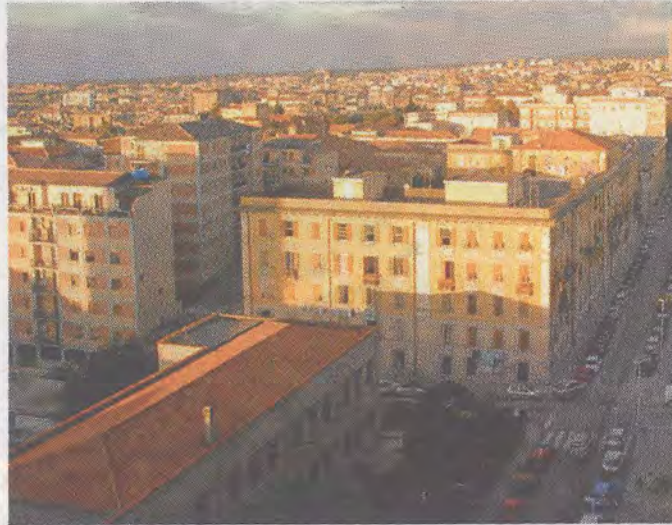
Una zona residenziale di Sassari
