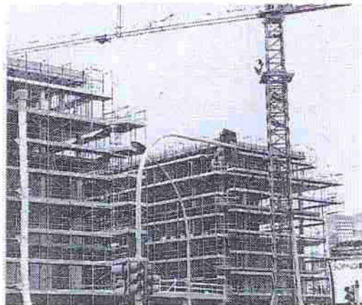
Un cantiere edile, a destra Francesco Porcu
